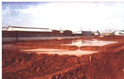
Bãi phơi và lắng bùn đỏ tại NMHC Tân Bình
